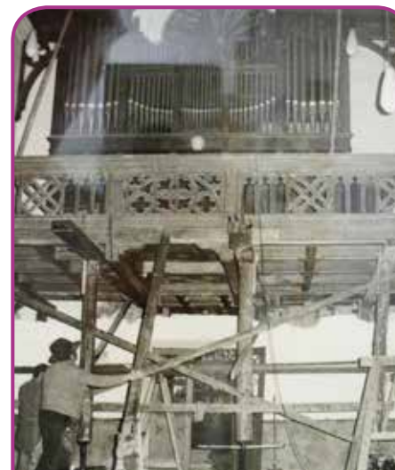
1976: Absenken der Empore samt Walcker-Orgel um 50 cm zur Verbesserung der Akustik
