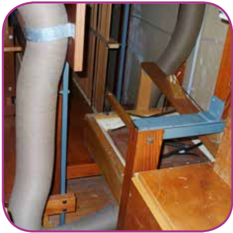
5 Gebläseanlage mit Motorkasten, Regulierbalg und Windkanäle zu den Windladen
